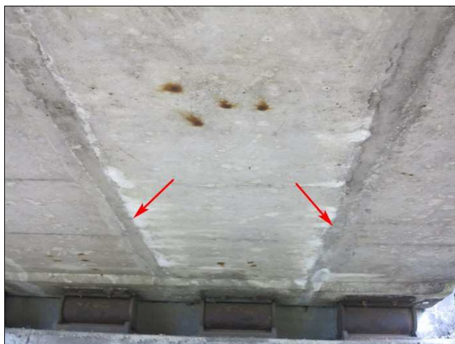
Foto č. 5 - K 03 průsaky s výluhy v podélné spáře u O 02 vpravo.
