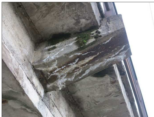
Foto č. 4 - K 02 nepravidelné trhliny s průsaky a výluhy konzole vpravo.
