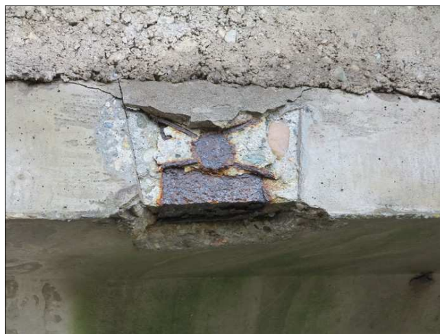
Foto č. 2 - K 01 degradace betonu a koroze příčných předpínacích tyčí.
