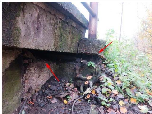
Foto č. 10 - O 02, sesedlý poslední kus křídla vpravo, odtržená patka a římsový nosník bez podpory.
