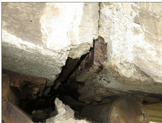
Foto č. 1 - K 01 odkryté kotvy nad P 01 vlevo.
