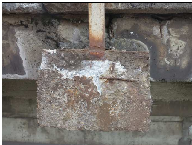
Foto č. 3 - K 02 degradace betonu konzole č. 3 vlevo - nad komunikací.
