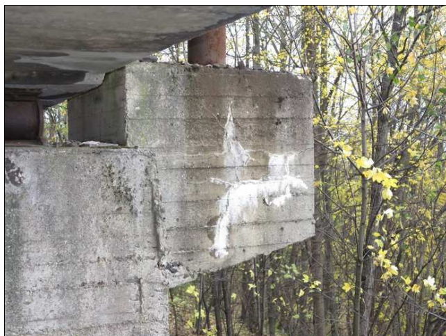
Foto č. 9 - P 02, nepravdivé trhliny s průsaky v konzole sloupu trakčního vedení.
