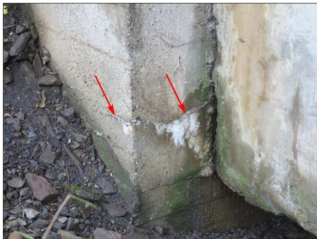
Foto č. 7 - O 01, trhлина závěrné zdi vpravo u hrany.
