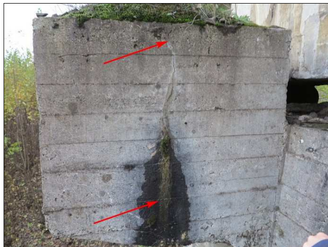
Foto č. 8 - P 01, svislá trhлина s průsakem konzole směrem do 2. otvoru-
