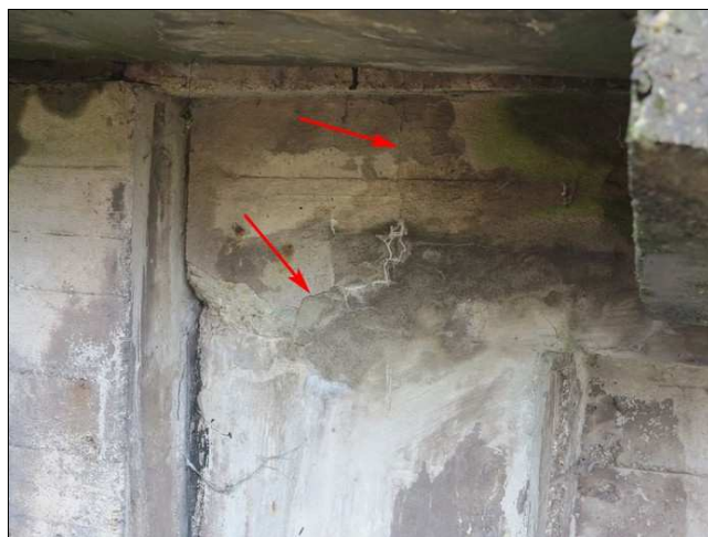
Foto č. 6 - K 02 svislá a podélná trhlina z líce konstrukce vlevo nad O 02.
